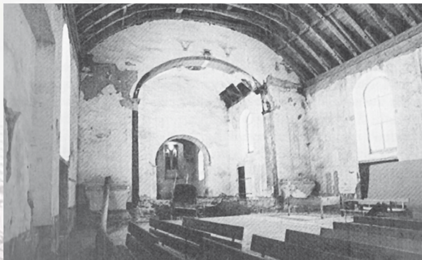
Innenansicht mit sichtbarem Dachgebälk 1985
