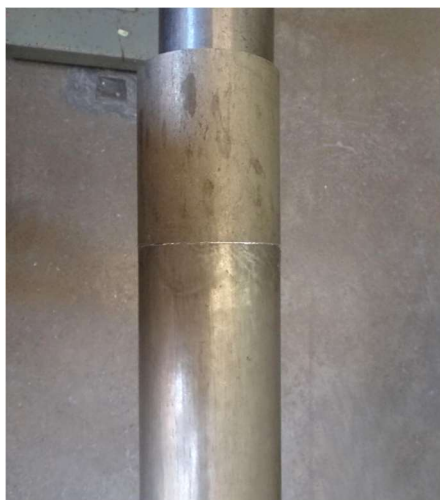
Canna di prospetto dopo l'allungamento
