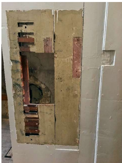
La registrazione originaria era nascosta da un pannello (sx) La ricostruzione della registrazione con il comando del tiraripieno (dx)
