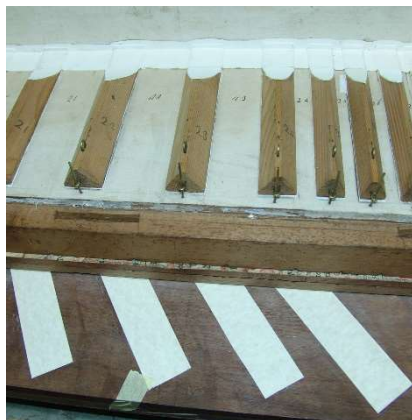
Vista delle stecche dopo la rimozione delle coperte (sx) Ventilabri del somiere maestro re-impellati (dx)
