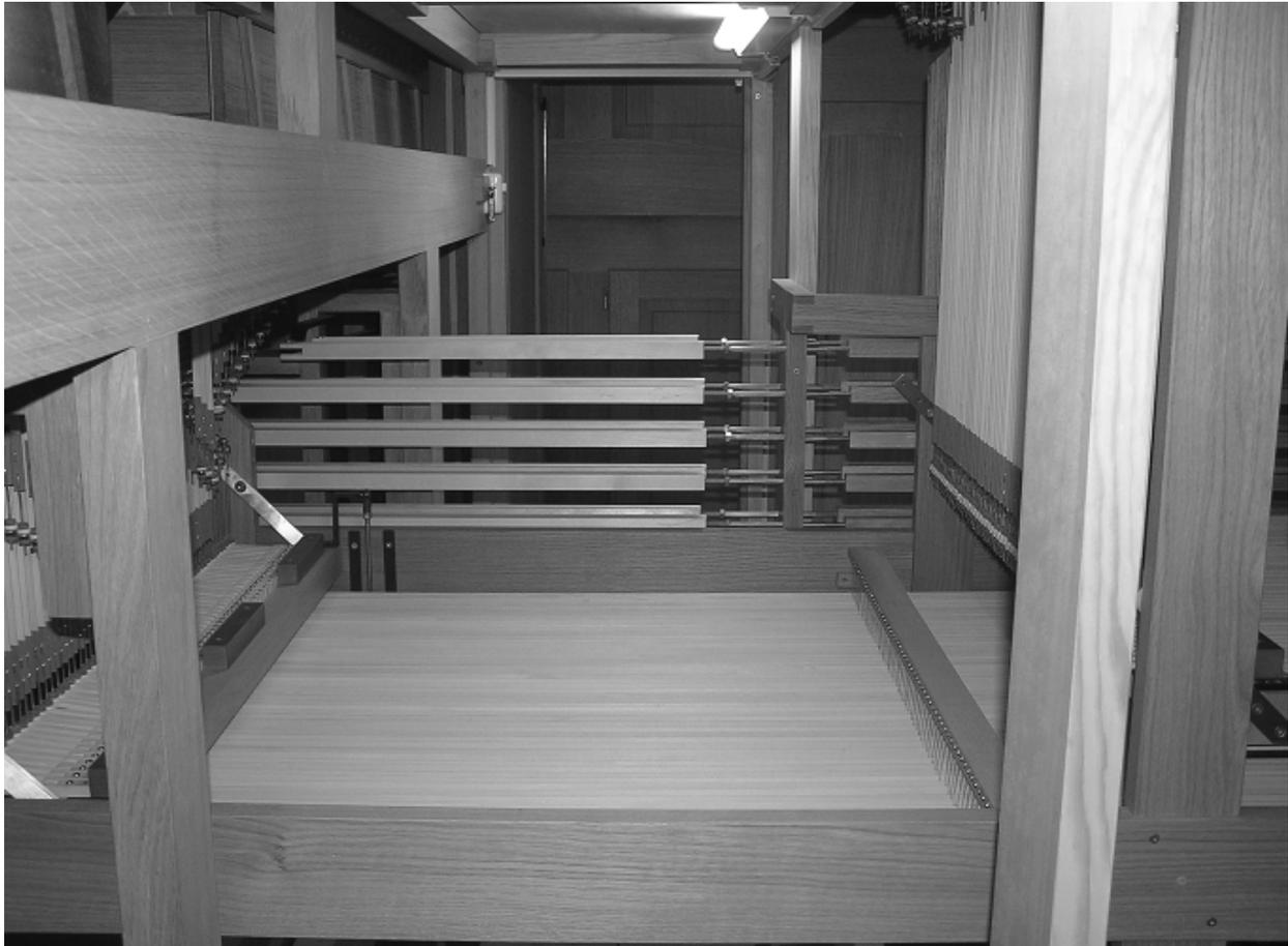
Blick von der linken Seite in den Mittelgang des Hauptgehäuse-Unterteils: Im Vordergrund quer verlaufend die Traktur zum Schwellwerk (II. Manual), dahinter die Registerstangen zu den Schleifen des Schwellwerks. Rechts hinter dem senkrechten Balken die zum Hauptwerk aufsteigende Traktur des I. Manuals. Foto: F.L.
