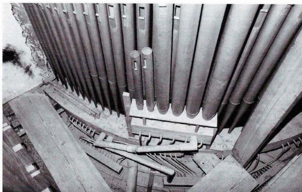
Vue arrière de la Montre: ouvertures pratiquées dans les tuyaux du Violoncelle 8' pour les transformer en Choralbasse 4' (Photo François Comment)
