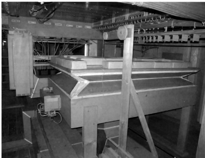
Ce régulateur de pression est muni d'un dispositif de trémolo, visible à gauche. (Photo François Comment)
