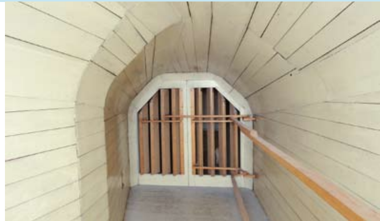
Blick in den Schalltrichter hin zur Öffnung in der Kuppel (1.6m x 1.4m). Die Länge des Schalltrichters beträgt 6.9m. Es ist aussergewöhnlich, dass sich auch hier nochmals Schalousieschweller befinden. Die Steuerung erfolgt durch die Holzstangen (rechts).
