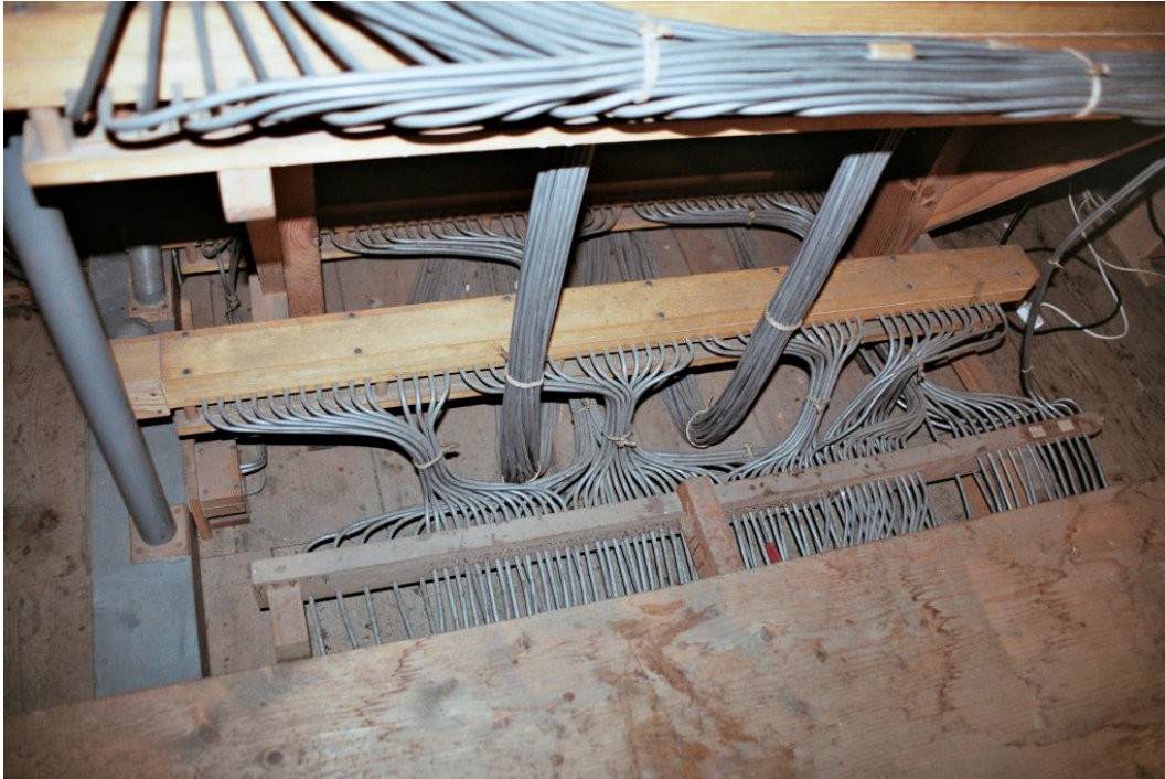
Sauber verlegte Pneumatik
