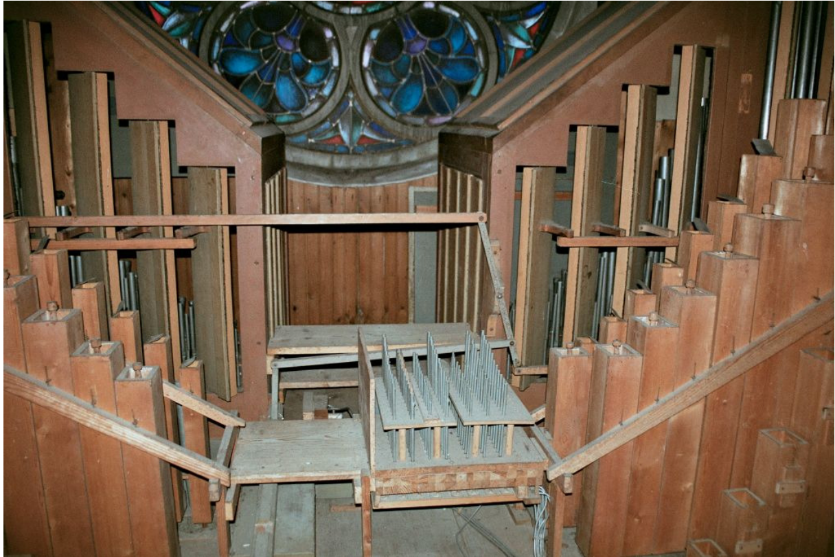
Der zweigeteilte Schwellkasten und die externen Superoctavpfeifen der Register des Schwellwerks
