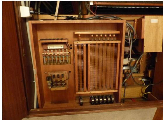
Die veraltete Elektrik war sehr unübersichtlich angeordnet und schlecht zugänglich. Der Plastik der Kabelverbindungen wurde durch die Jahre brüchig und klebrig. Unsichere Lötstellen verursachten Wackelkontakte, die Reparaturen wurden aufwendig, da wichtige Bestandteile nicht mehr erhältlich waren.
