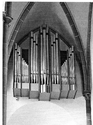
L'Auxiliaire de l'orgue Rieger de la cathédrale d'Essen, sans console propre, suspendu dans un bas-côté et doté de 12 jeux, dont un Tuba 8' et une Bombarde en 16'/8'/4'. (Photo www.rieger-orgelbau.com )
