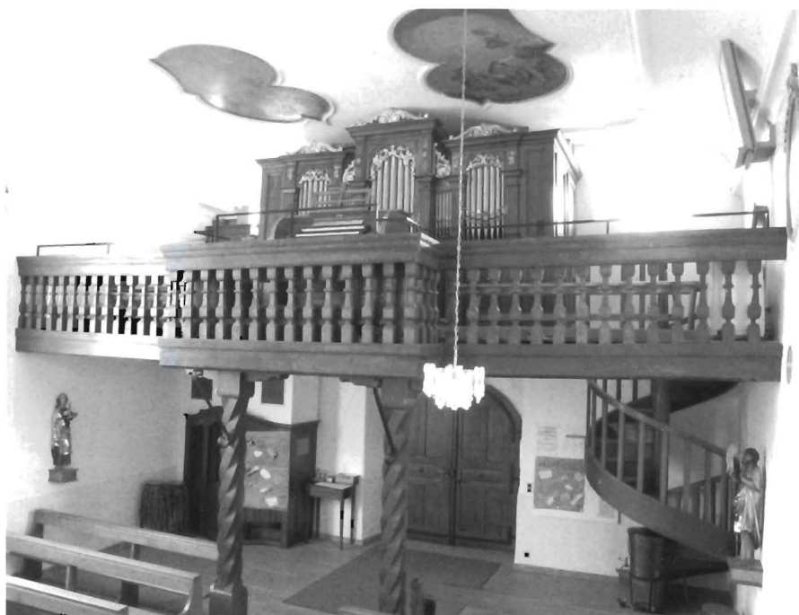
Vu l'exiguïté de la tribune, le banc de l'organiste touche la balustrade. A la demande du titulaire, une barre de fer y a été ajoutée pour des raisons de sécurité. (Photo François Comment)
