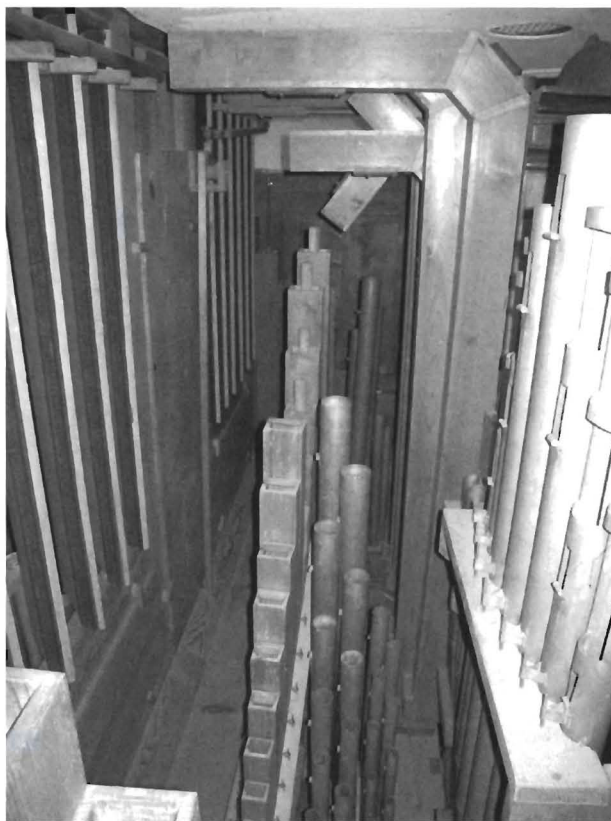
Les jalousies du Récit. les tuyaux coudés du Grand-Orgue et la Montre. A droite dans le plafond une ouverture ajoutée lors de la dernière restauration pour que la soufflerie aspire l'air de la nef. (Photo François Comment)
